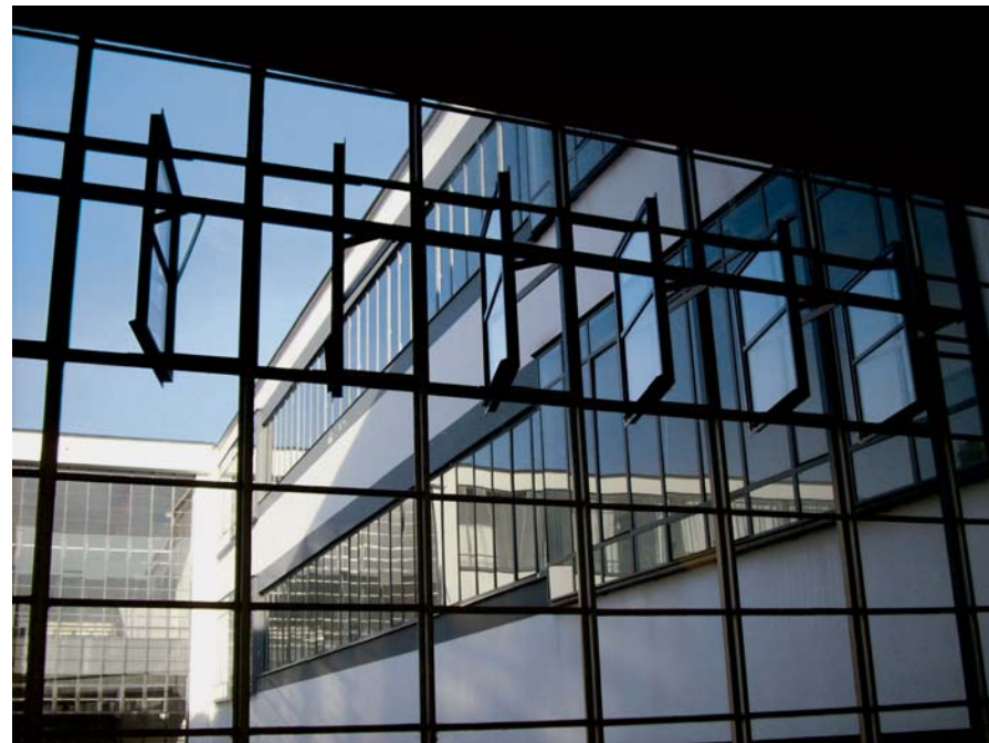
Баухауз в Дессау. Фрагменты стеклянного фасада с автоматически открывающимися окнами. © Photo Astrid Volpert
