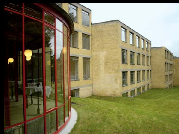
Профсоюзная школа в Дессау. Вид из столовой-кафе на секционные дома-общежития. Архитектор — Ханнес Майер совместно с Хансом Виттвером. © Photo Astrid Volpert
