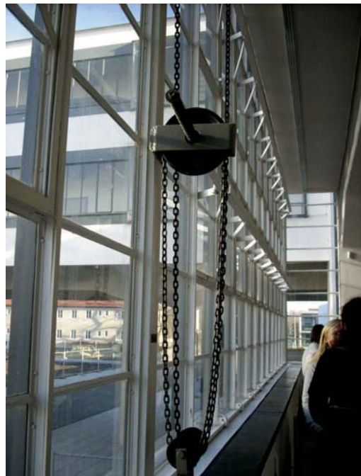
Баухауз в Дессау. Фрагменты стеклянного фасада с автоматически открывающимися окнами. © Photo Astrid Volpert
