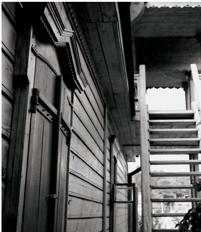
Дом Павла Кузнецова. Лестница на мансарду
